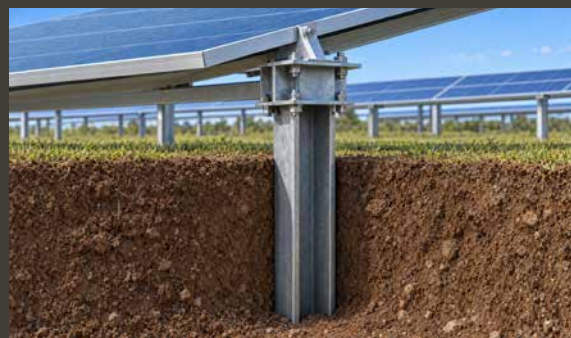
Direktmontage: Pfosten wird direkt in den Untergrund gerammt.
