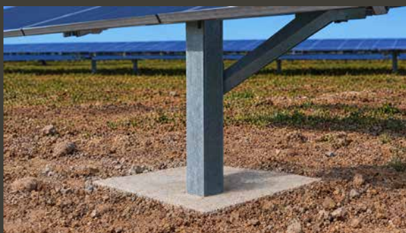
Betonfundament – Stütze auf einem gegossenen Punktfundament.
