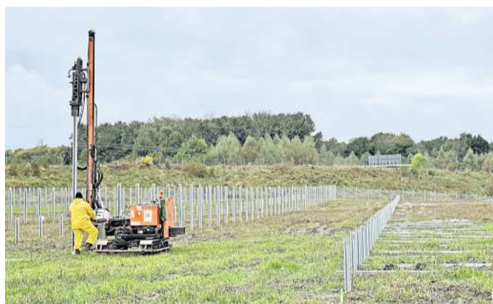
Die Pfosten für den Solarpark werden mit einer Ramme ins Erdreich geklopft – bis zu 2,50 Meter tief.
