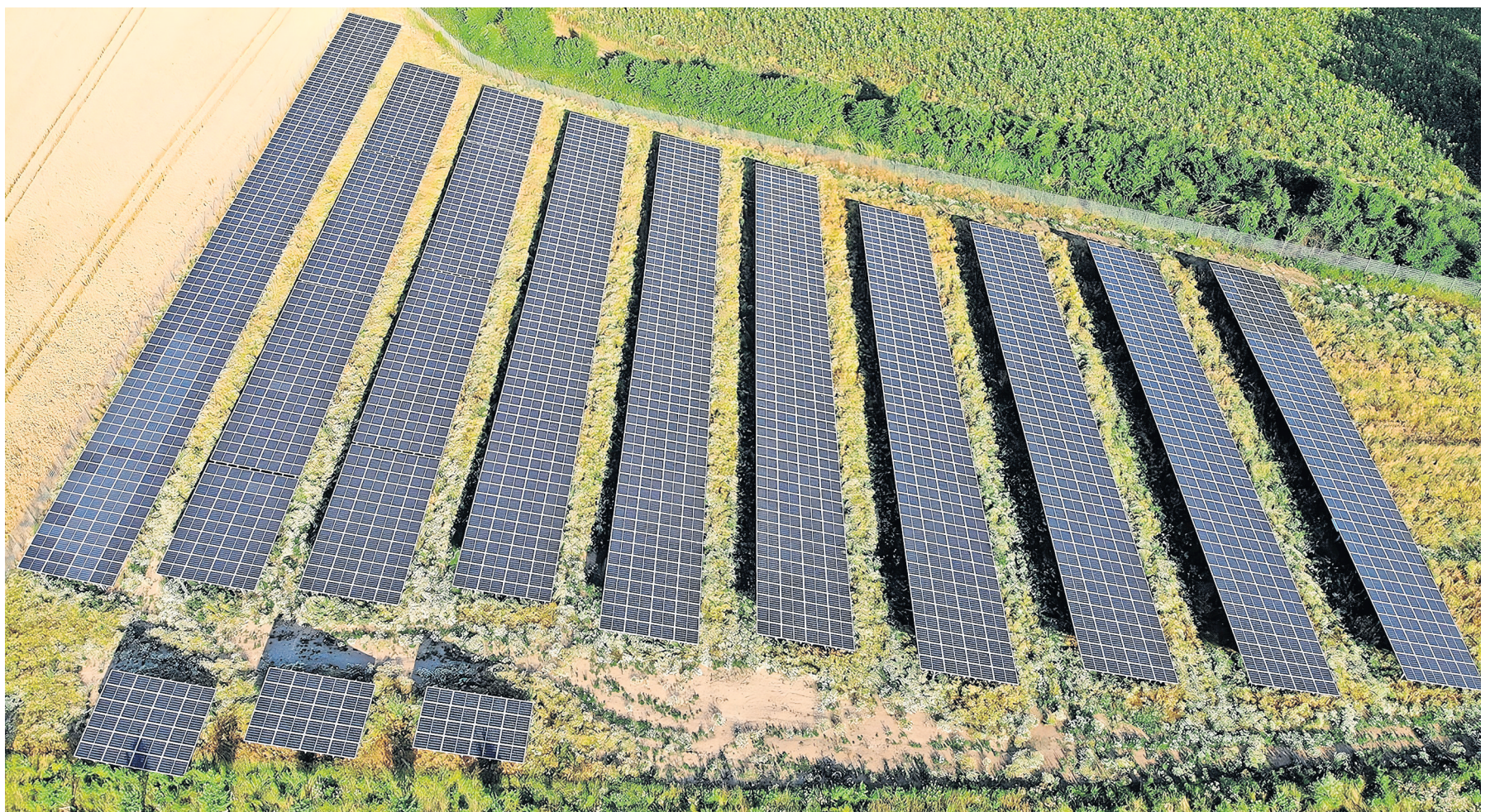
Auf einem 26 Hektar großen Acker im Süden von Badendorf soll ein zweiteiliger Solarpark entstehen. Die erste Freiflächenanlage mit 16.000 PV-Modulen wird noch in diesem Jahr errichtet.
