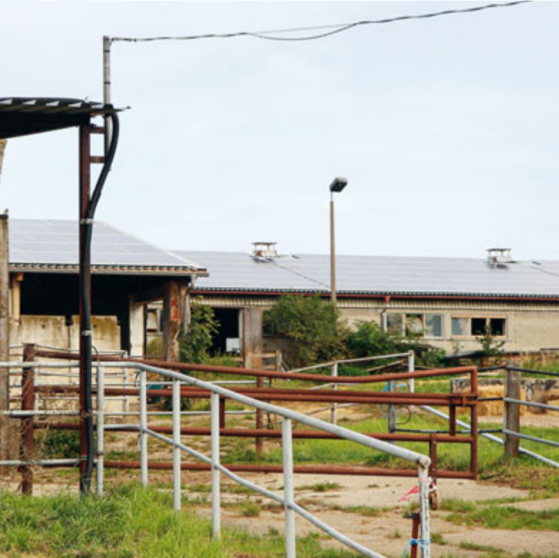
Gärtner hat auf insgesamt sechs Gebäuden in der Agrargenossenschaft neue Dächer verlegen lassen.
