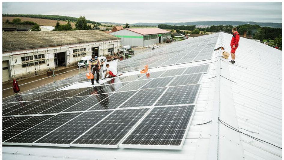
● Auf die sanierten Dächer wurden insgesamt rund 925 Kilowatt Photovoltaik installiert.
